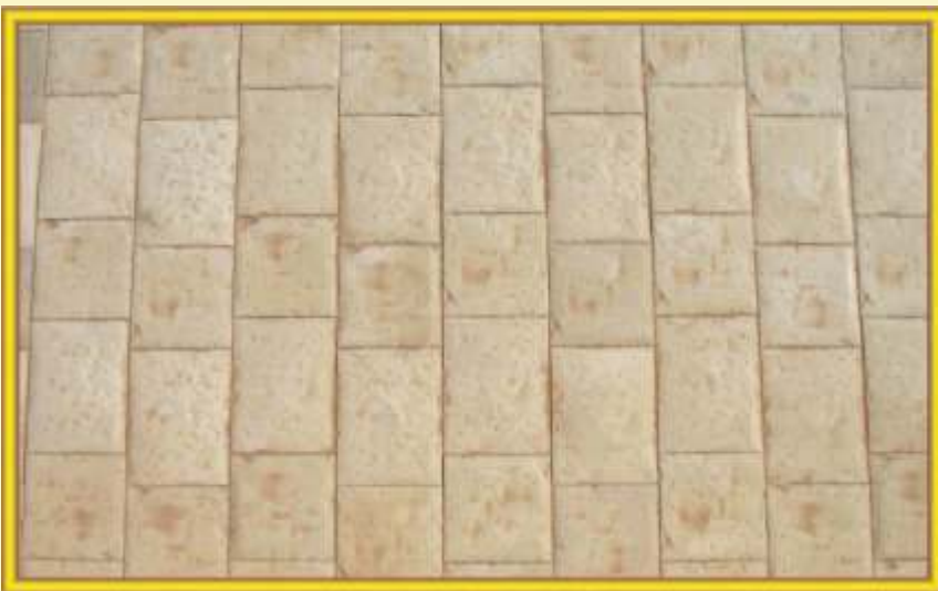
PAV 51 - Particolare pavimento basolato liscio
