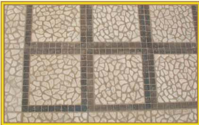
Particolare pavimento Tivoli a quadroni
