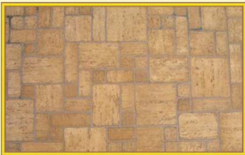
Particolare pavimento Tivoli
