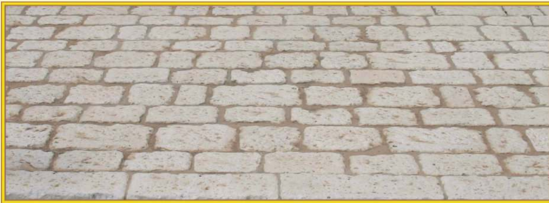
PAV 18 - Pavimento basolato
