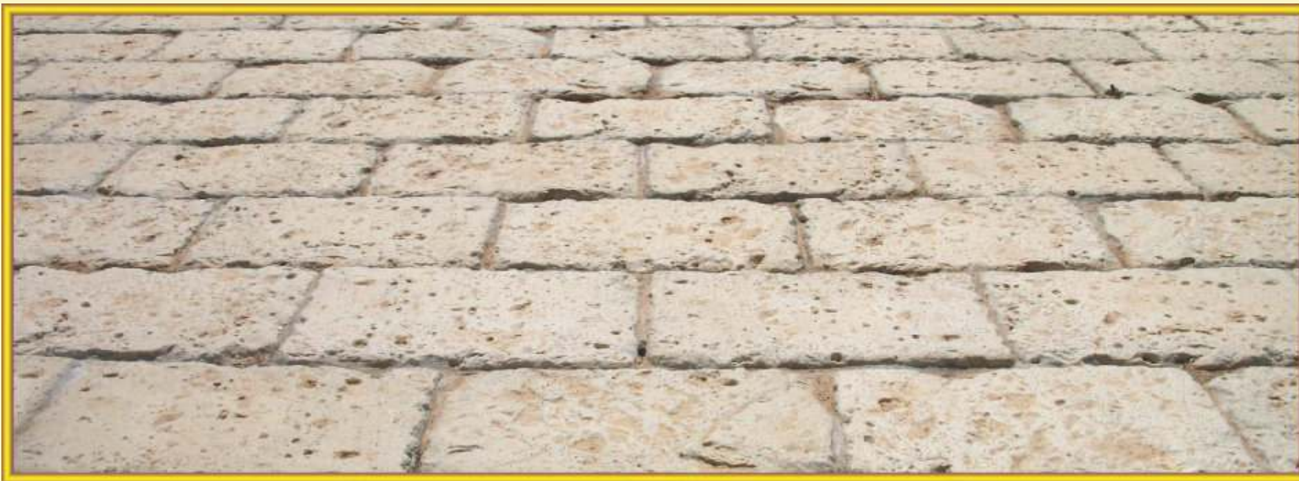
PAV 21 - Pavimento basolato
