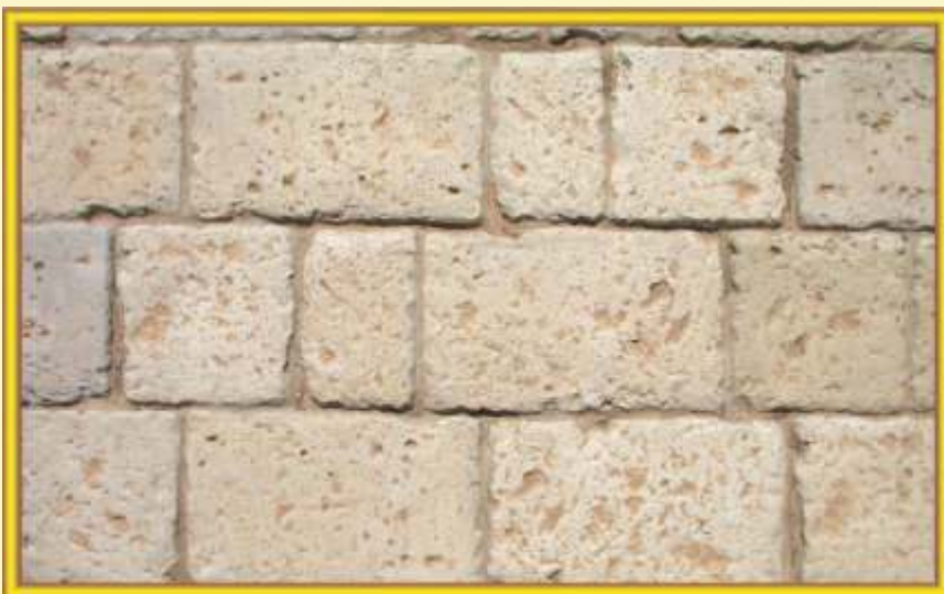
PAV 21 - Pavimento basolato
