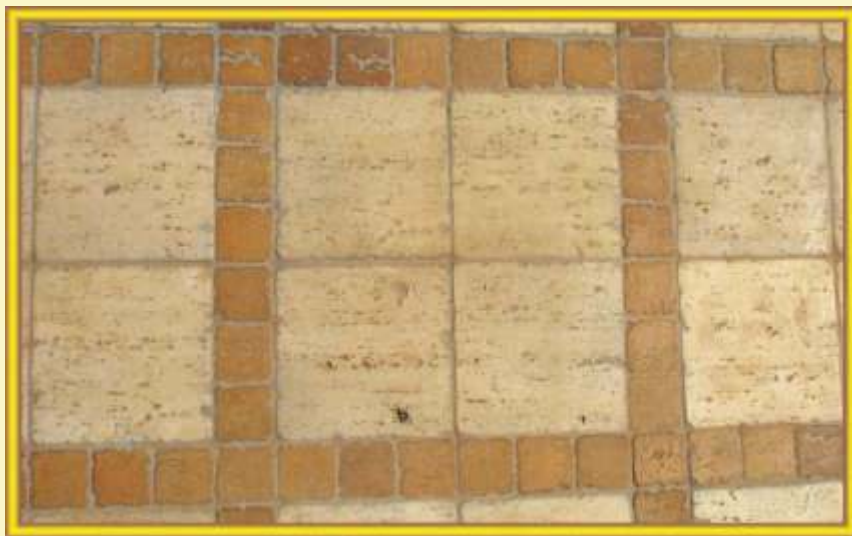
Particolare pavimento Tivoli a quadroni
