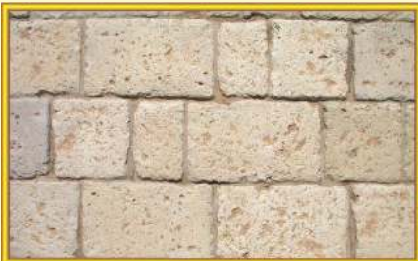
PAV 21 - Pavimento basolato
