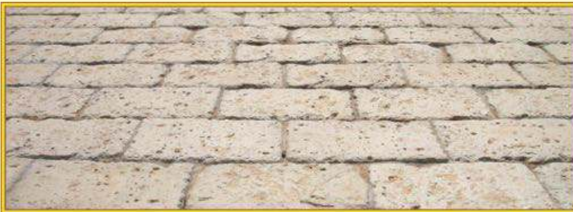
PAV 21 - Pavimento basolato
