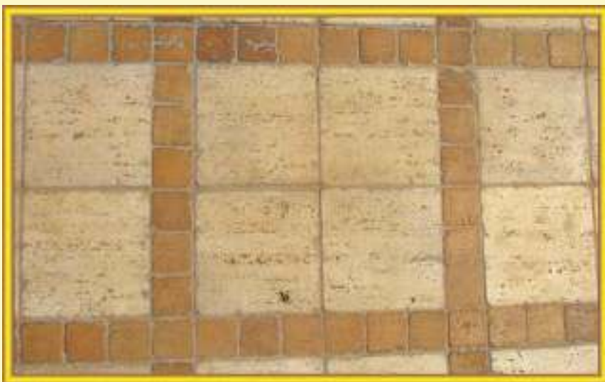
Particolare pavimento Tivoli a quadroni
