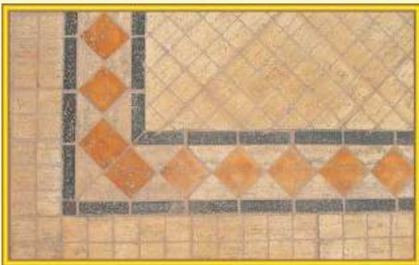
Particolare pavimento Tivoli 80
