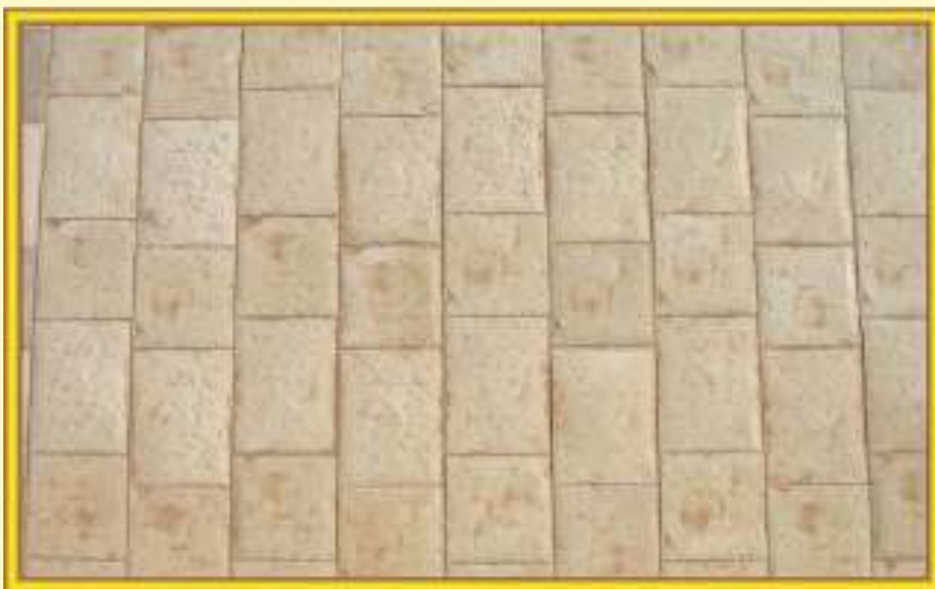
PAV 51 - Particolare pavimento basolato liscio
