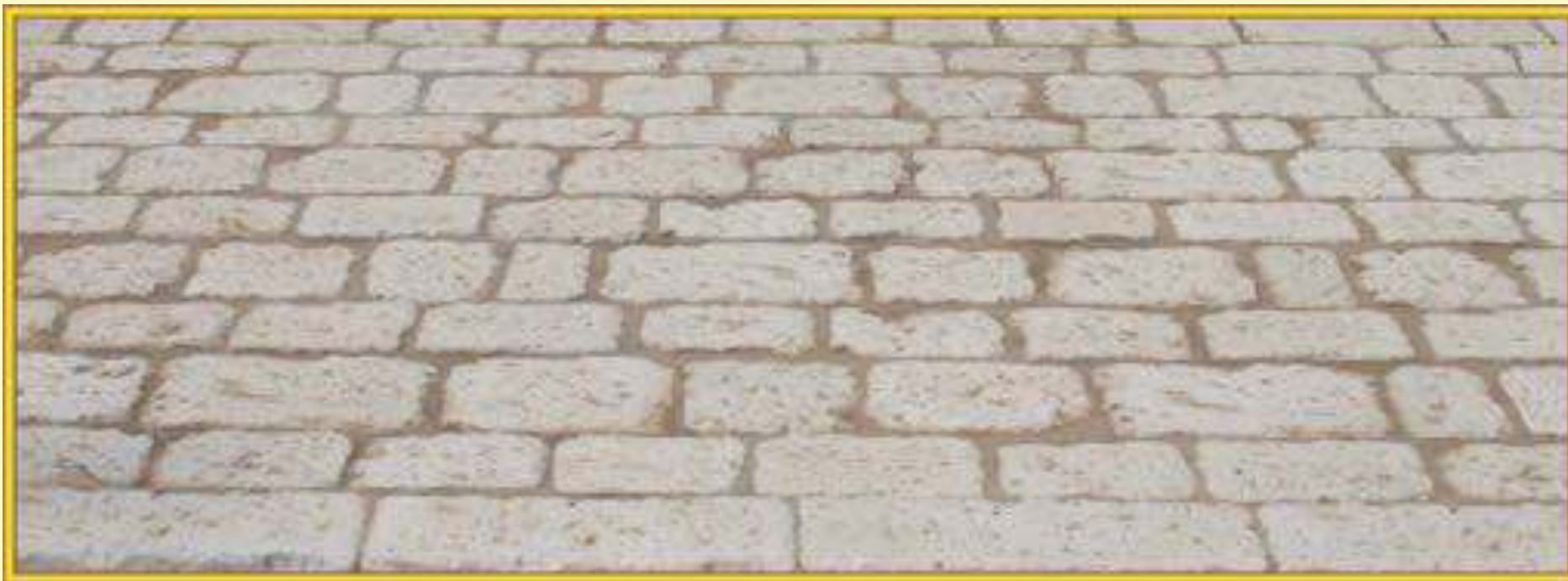
PAV 18 - Pavimento basolato
