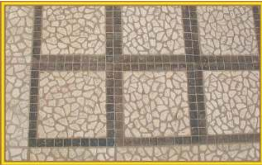
Particolare pavimento Tivoli a quadroni
