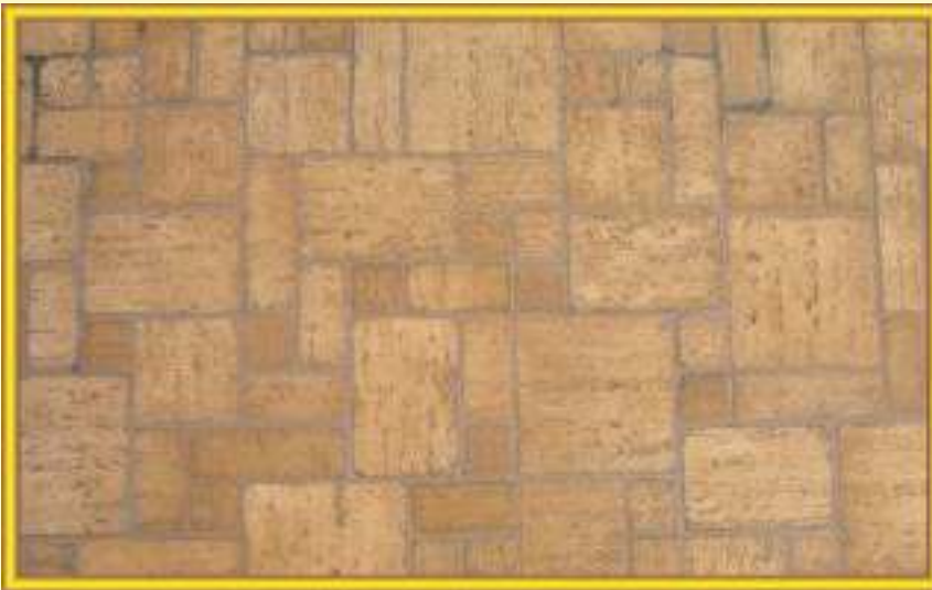
Particolare pavimento Tivoli
